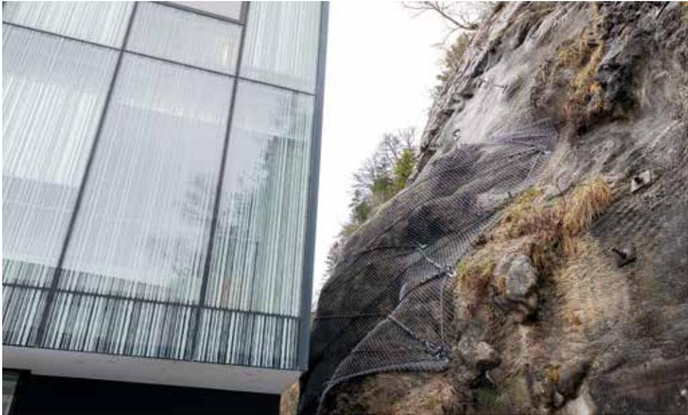
Abb. 7: Die Felssicherungsarbeiten an der Kapuzinerbergwand hinter dem Haus der Stadtgeschichte wurden im Dezember 2021 abgeschlossen (Foto: Stadt Salzburg, Info-Z).
